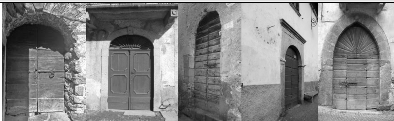
P.2.a – Portale a doppio battente in legno cieco, cornice in pietra, arco a tutto sesto in pietra
